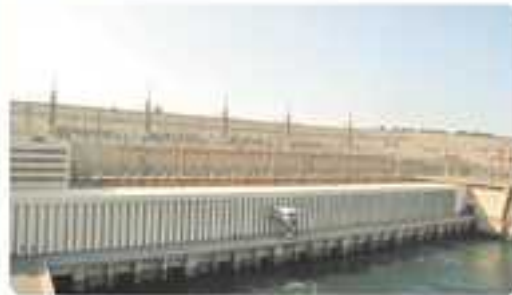
محطة كهرباء السد العالي
