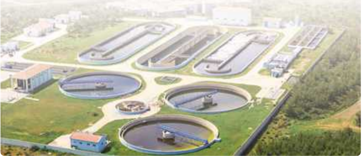
محطة معالجة مياه الصرف
